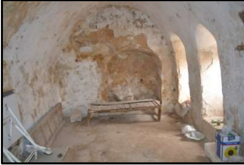
Şekil 10: Sıcak ve soğuk havadan korunmak için yapılmış kalın duvarlı bir oda.
